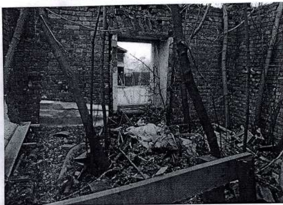
3. Внутреннее пространство флигеля. Вид на западную стену.
