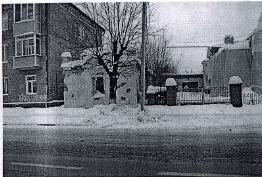
1. Западный фасад флигеля. Вид по ул. Красных Партизан.
