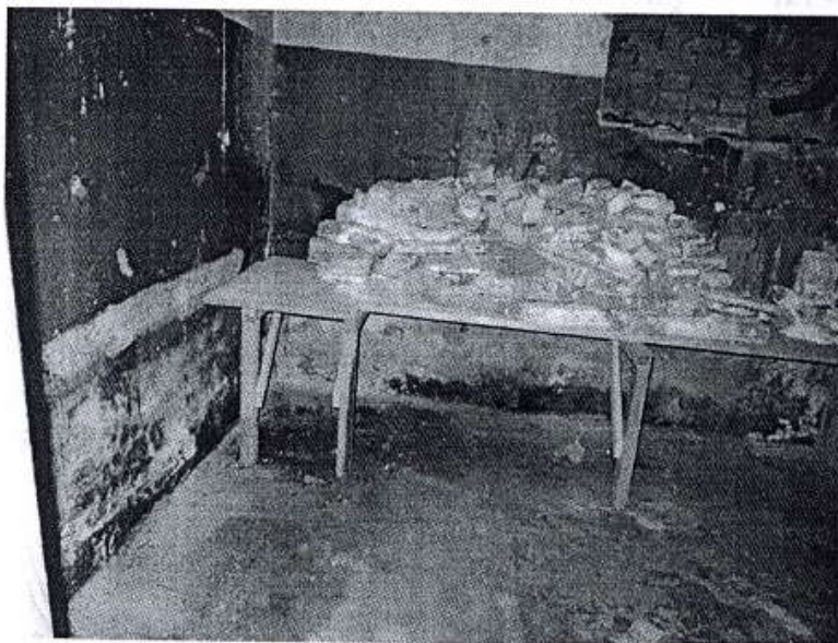
Демонтированная керамическая плитка западного фасада тамбура
