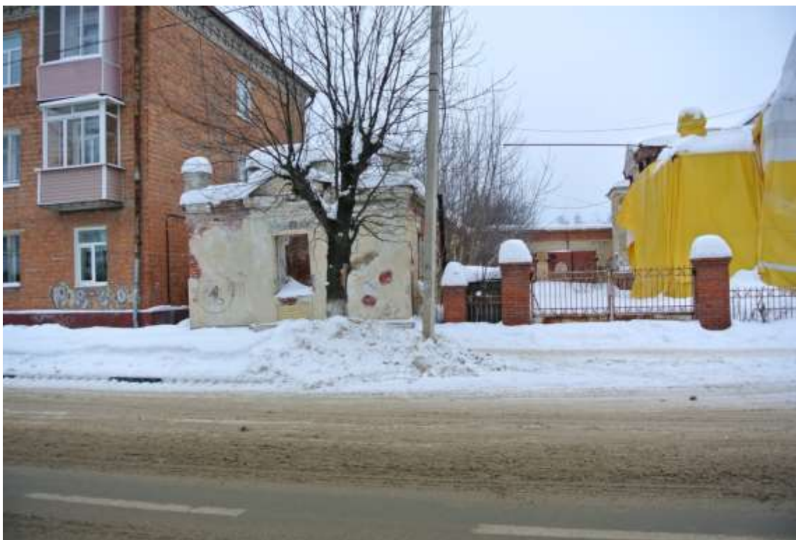
Западный фасад флигеля. Вид по ул. Красных Партизан.
