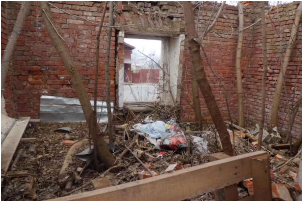
2. Внутреннее пространство флигеля. Вид на западную стену.
