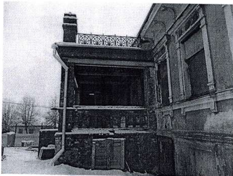
Фрагмент западного фасада
