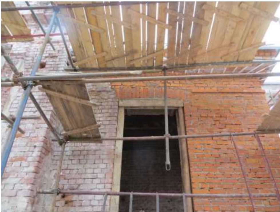
Фрагмент восстановленного северо-западного угла парадного тамбура
